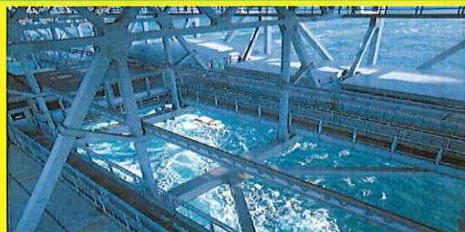
大鳴門橋遊歩道 渦の道
